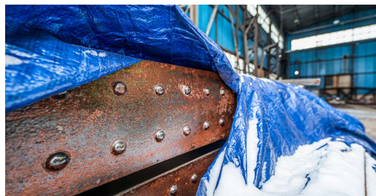
Fragment stalowej konstrukcji dawnej hali montażowej. Po zabiegach konserwacyjnych wszystkie elementy hal fabrycznych wrócą na swoje miejsce i będą stanowić o unikatowości nowego centrum Dąbrowy Górniczej.
