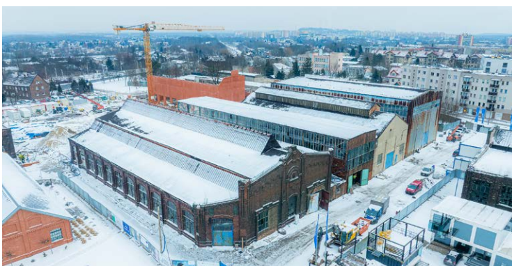
Widok na plac budowy 1. i 2. etapu nowego centrum Dąbrowy Górniczej, czyli prawie 2 hektary przestrzeni publicznych, które w perspektywie roku wypełnią się m.in. zieleńcami, drzewami, wodą, eksponatami z fabryki Defum oraz pięć rewitalizowanych hal.
